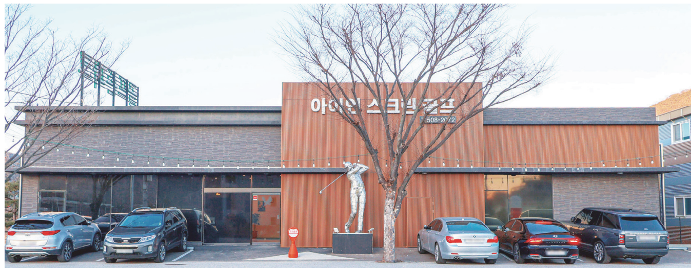
기장군 스크린 골프장 건축
